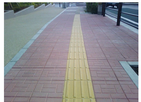
点字ブロック 施工写真
